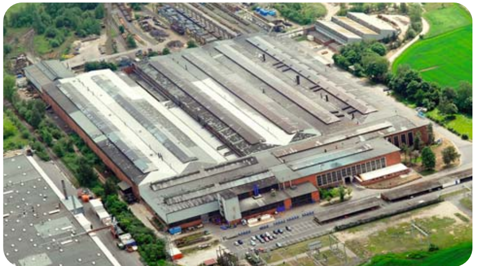
Das Rohrwerk Maxhütte in Sulzbach-Rosenberg von oben.
