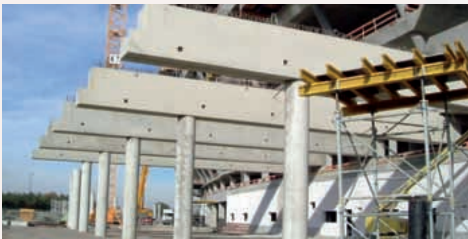
Der Einsatz von Beton-Fertigteilen beschleunigt den Bauablauf.
