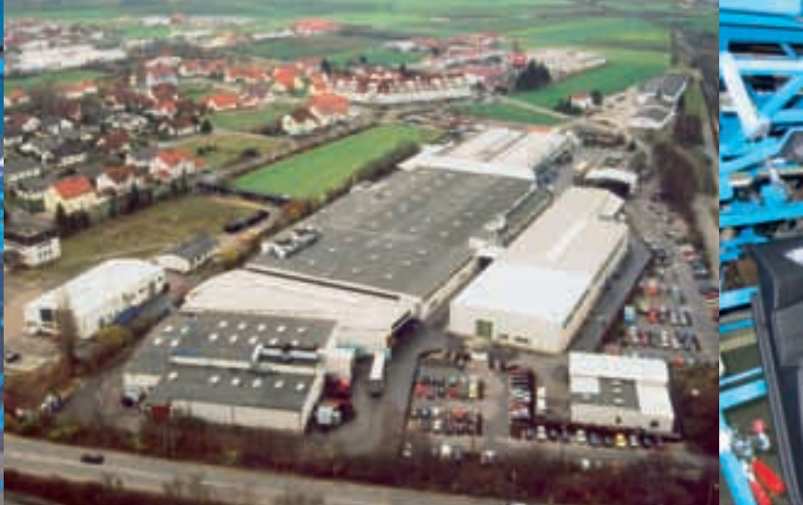
Das Werksgelände in Neustadt aus der Luft aufgenommen.
