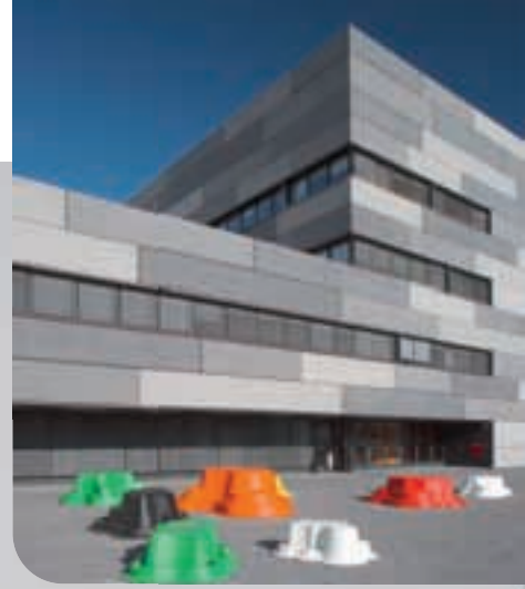
Institutsgebäude der TU Chemnitz mit vorgehäng- ter Fassade in drei ver- schiedenen Grautönen. Bild: Winkel
