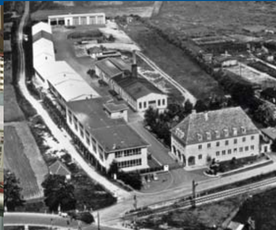
Die Neumarkter Fertigung in den 1950er Jahren.
